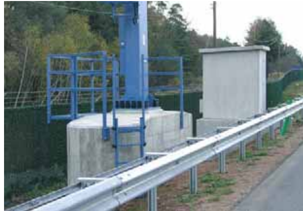
Die Fundamente für die Schilderbrücken waren ebenfalls Teil des Auftrages.
