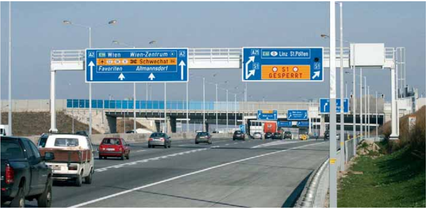
Für die Überkopfwegweiser wurden ca. 1000m 2 Folie Typ 3 DG und Anitau Overlayfilm benötigt.
