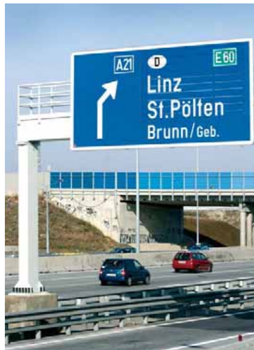
Für die Überkopfwegweiser wurden ca. 1000m 2 Folie Typ 3 DG und Anitau Overlayfilm benötigt.
