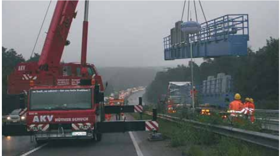
Innerhalb einer 15 minütigen Vollsperrung der Autobahn wurden die Schilderbrücken montiert.
