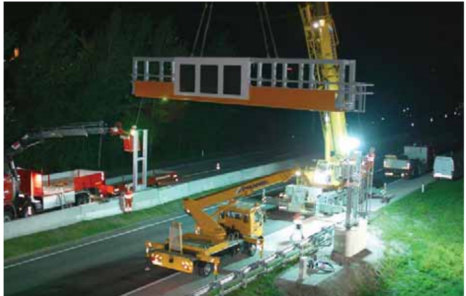
Die Montage der Schilderbrücken erfolgte in 100 Nachteinsätzen.
